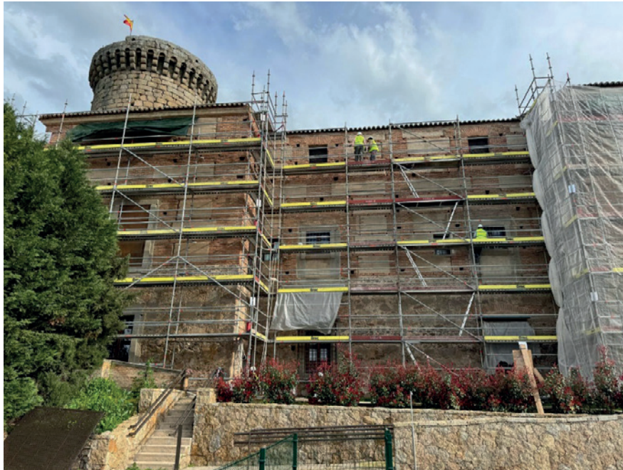
Figura 11. Fachada norte del Palacio de los Condestables durante los trabajos de limpieza y conservación
