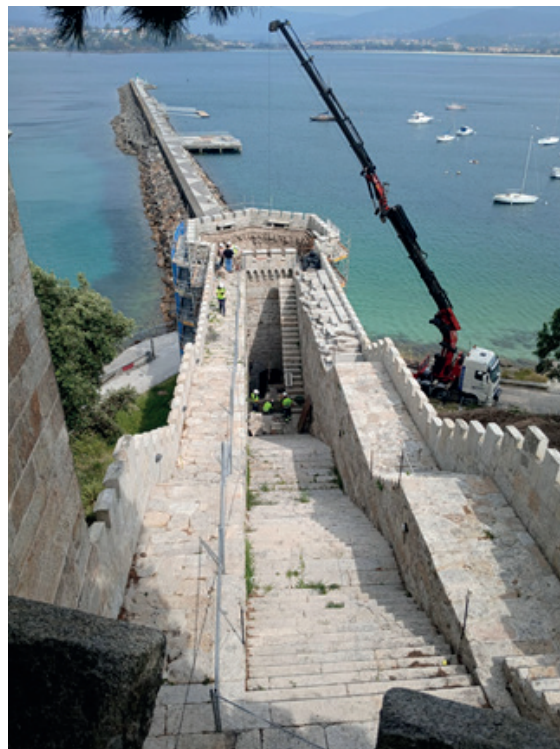
Figura 9. Torre de la Tenaza de la fortaleza de Monterreal durante los trabajos de limpieza y conservación
