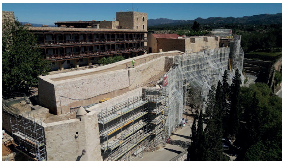
Figura 8. Murallas del Castillo de la Zuda durante los trabajos de limpieza y conservación
