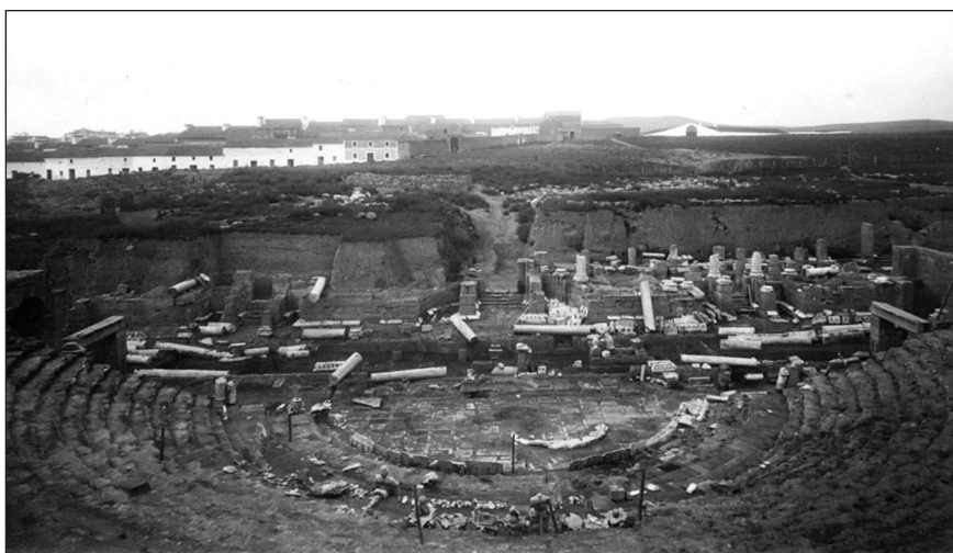
Figura 9 Teatro romano de Mérida antes del comienzo de las obras de reconstitución del frente de la escena, ca. 1915-1916
