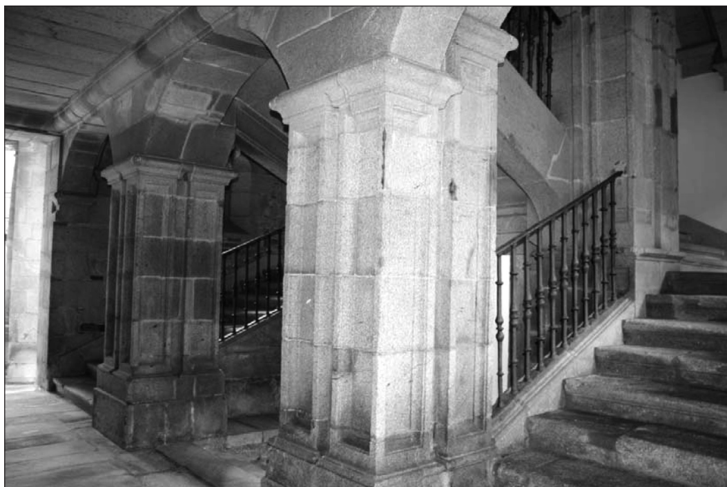
Figura 2 Situación de la escalera de entrepatios. Hospital Real
