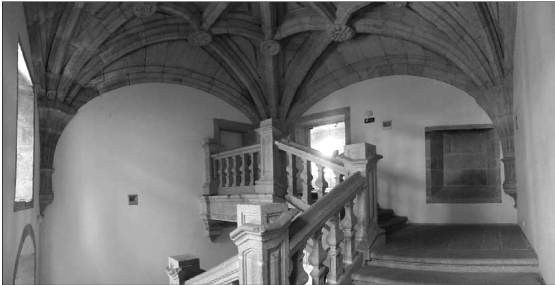
Figura 5 Aparato constructivo de la escalera. Santo Estevo de Ribas de Sil
