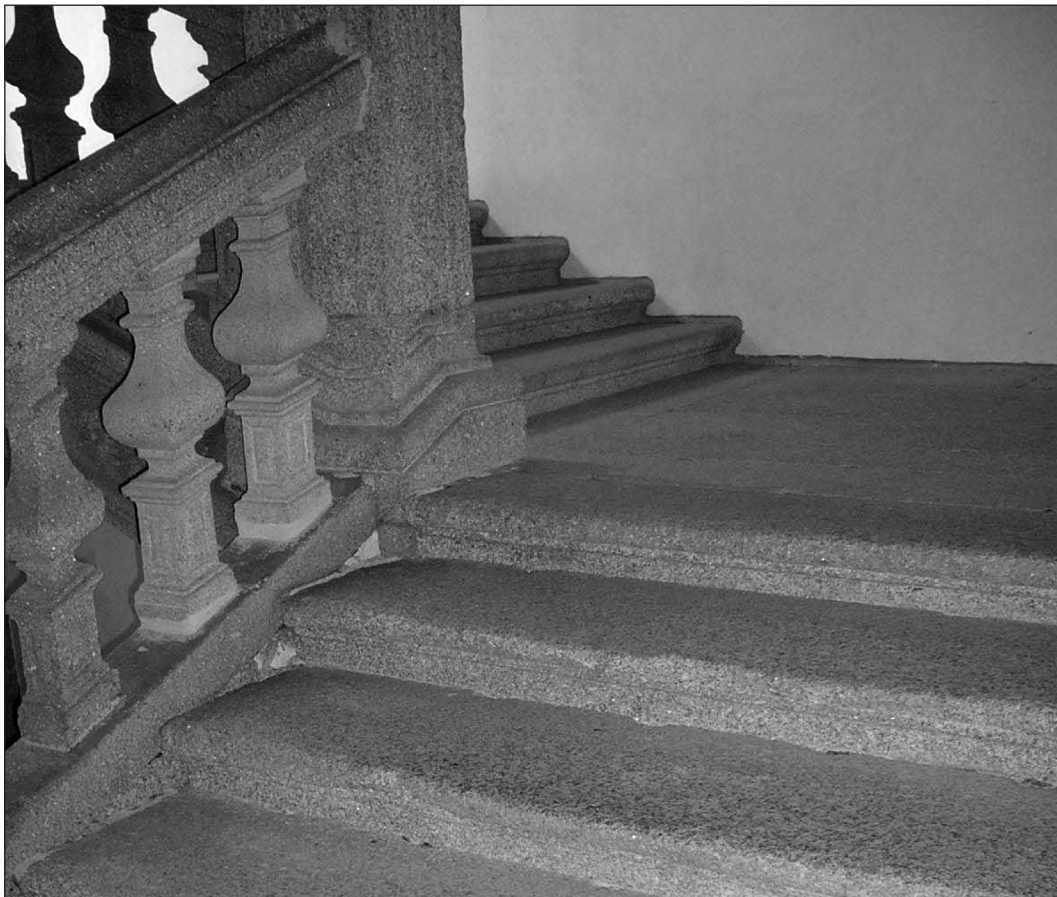
Figura 3 Tramo de la escalera abacial. Santo Estevo Ribas de Sil
