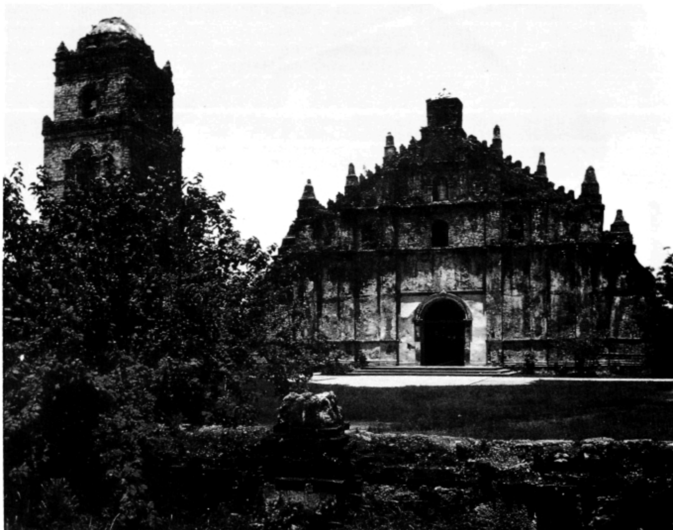
Iglesia de Paoay. Los campanarios solían construirse en el exterior para evitar que su derrumbamiento dañase la iglesia en caso de terremoto.
