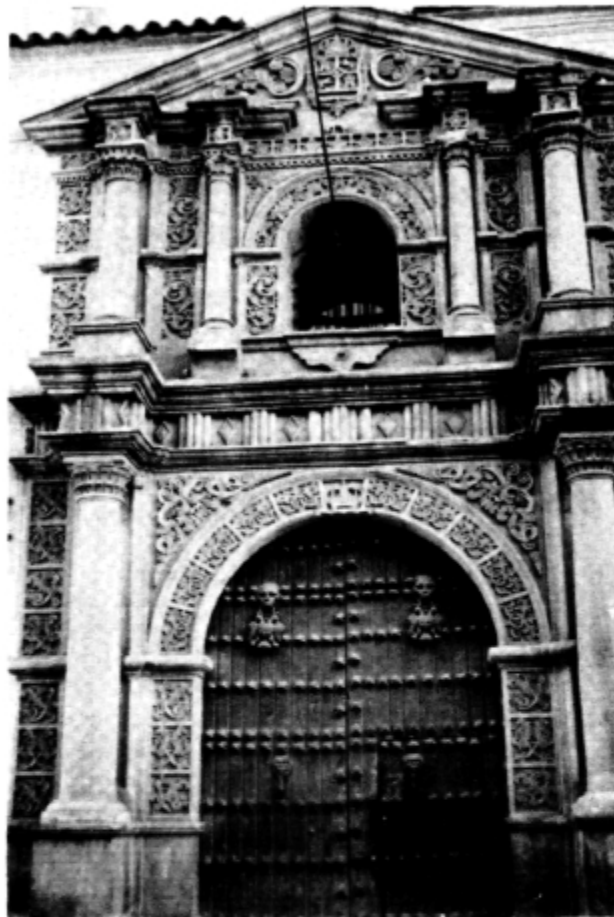
Fachada de la Casa de la Moneda.
