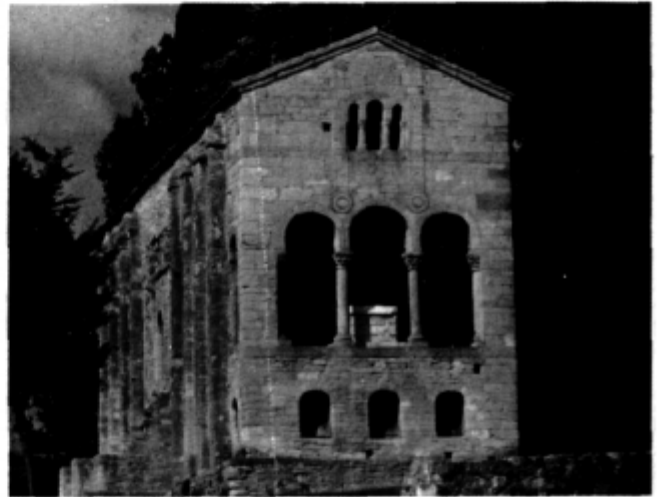
Oviedo, Iglesia Sta. M. a del Naranco.
