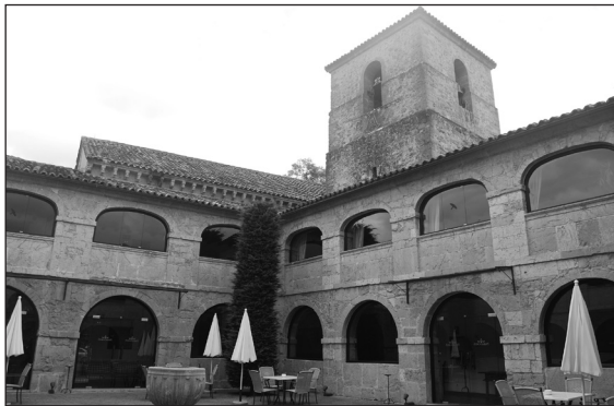
Figura 12 Claustro barroco del parador de Cangas de Onís
