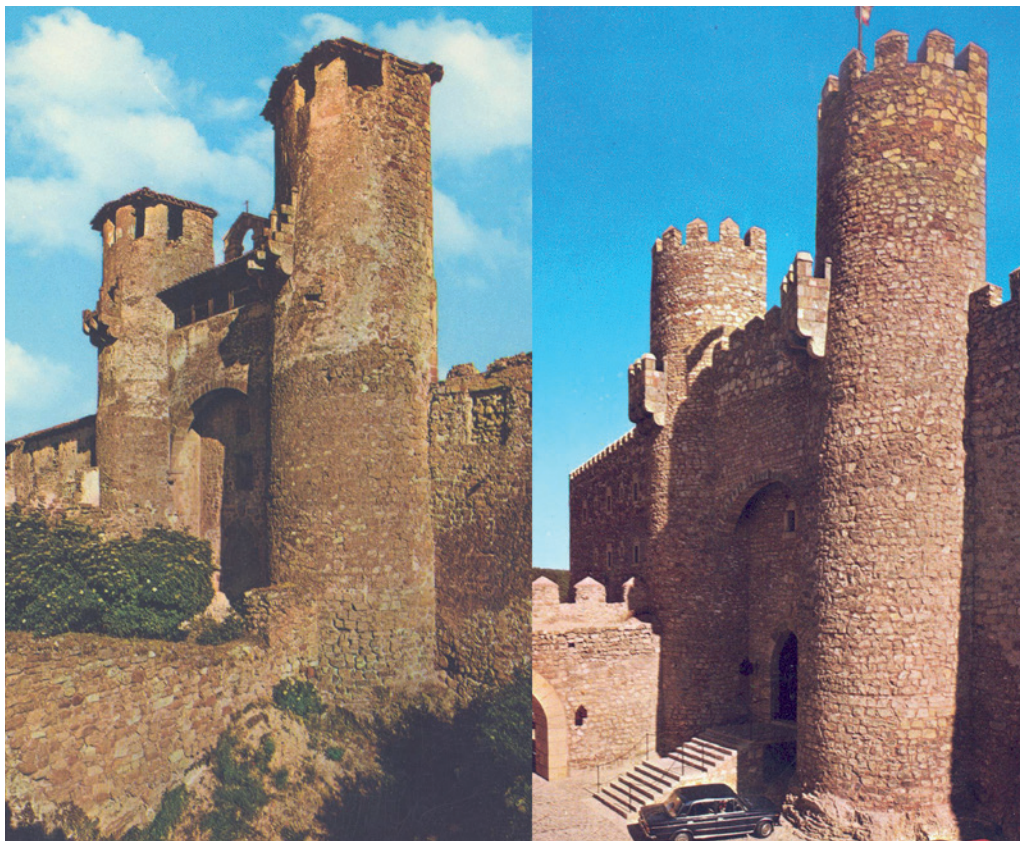
Figura 10. Antes y después del acceso al Parador de Sigüenza.
