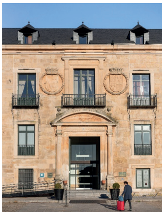
Figura 3. Fachada principal del Parador de Lerma
