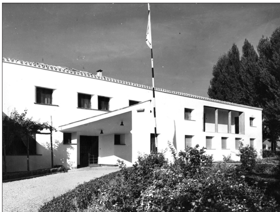
Figura 11 Albergue de carretera en La Bañeza, León. Ampliación (ca. 1960)
