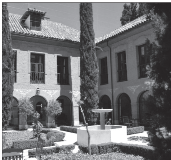
Figura 4 Parador de Chinchón. Claustro
