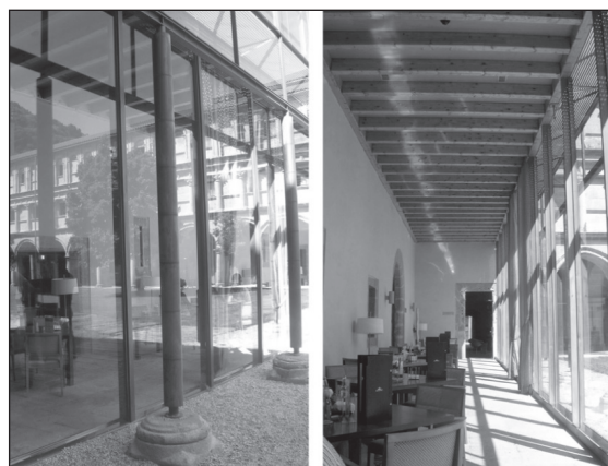
Figura 8 Parador de San Esteban de las Ribas del Sil. Detalle del muro cortina
