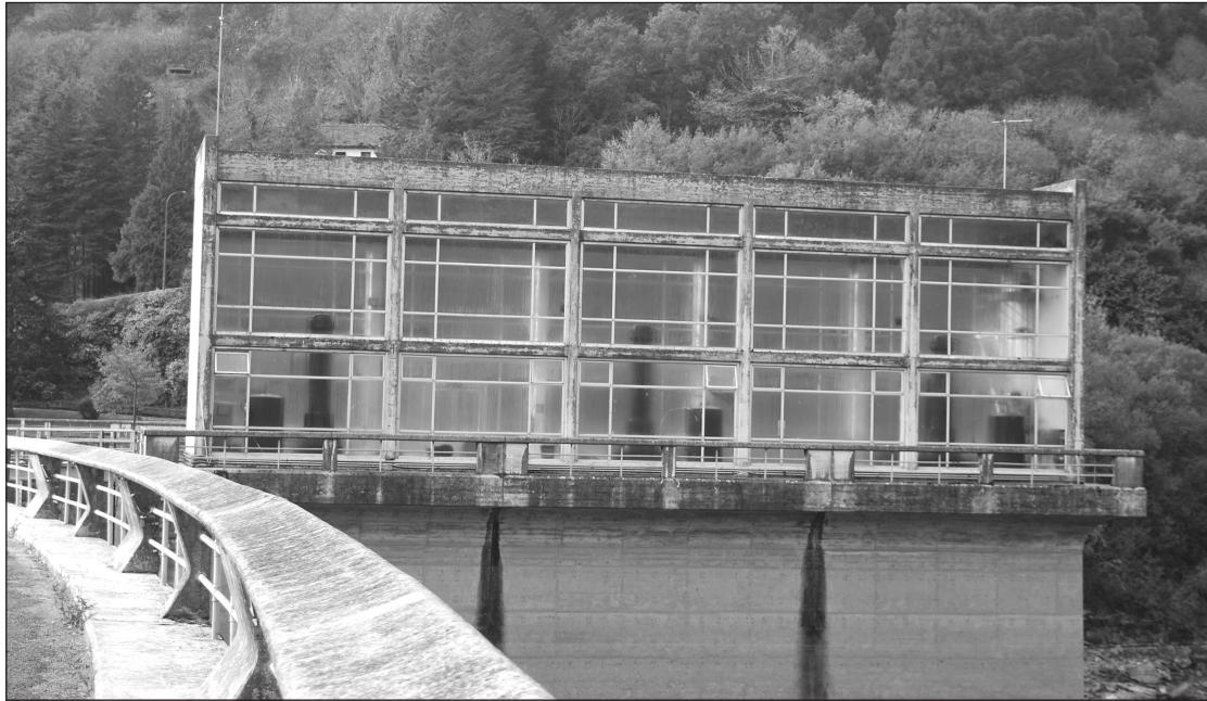
Figura 8 Subestación de la presa de Belesar
